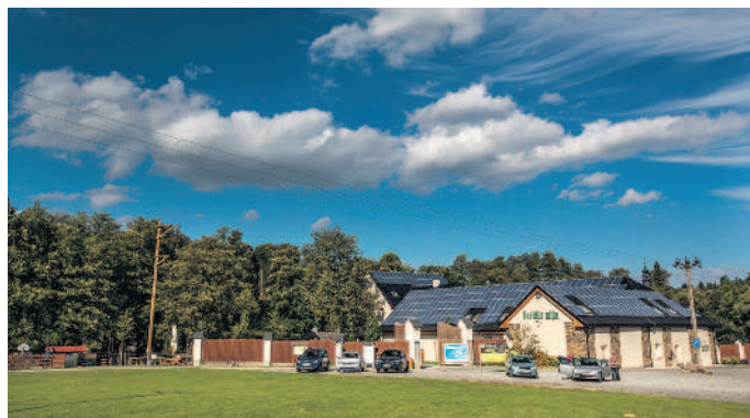
Solární panely pokrývají střechu penzionu i dalších budov v areálu.
