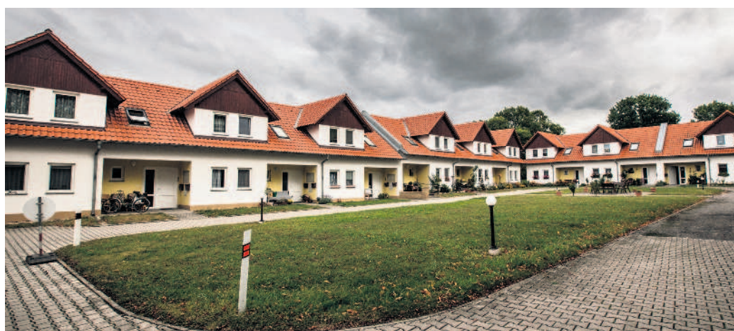
Teplota z bioplynové stanice a kotlů na biomasu zásobuje rodinné domy i veřejné budovy v obci Kněžice.
